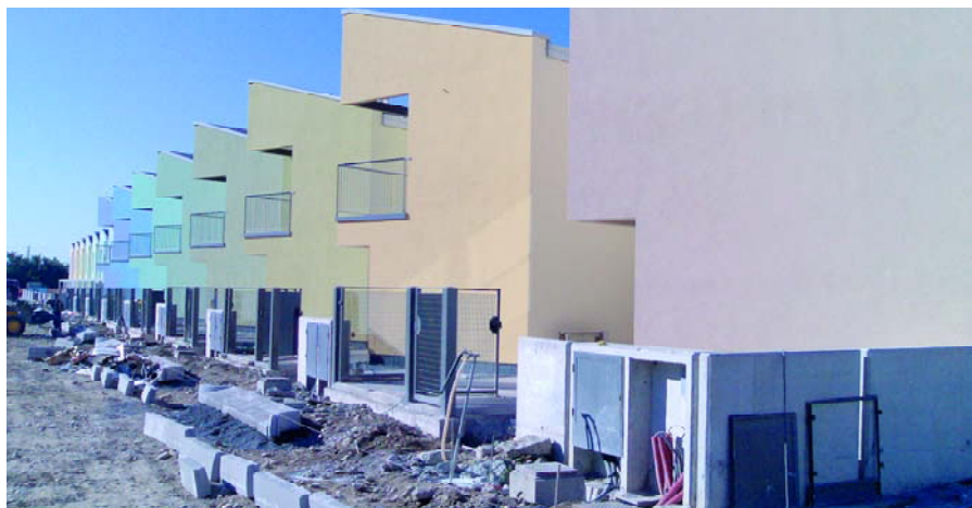
Alloggi in costruzione nel nuovo comparto del Villaggio Violino a Brescia
