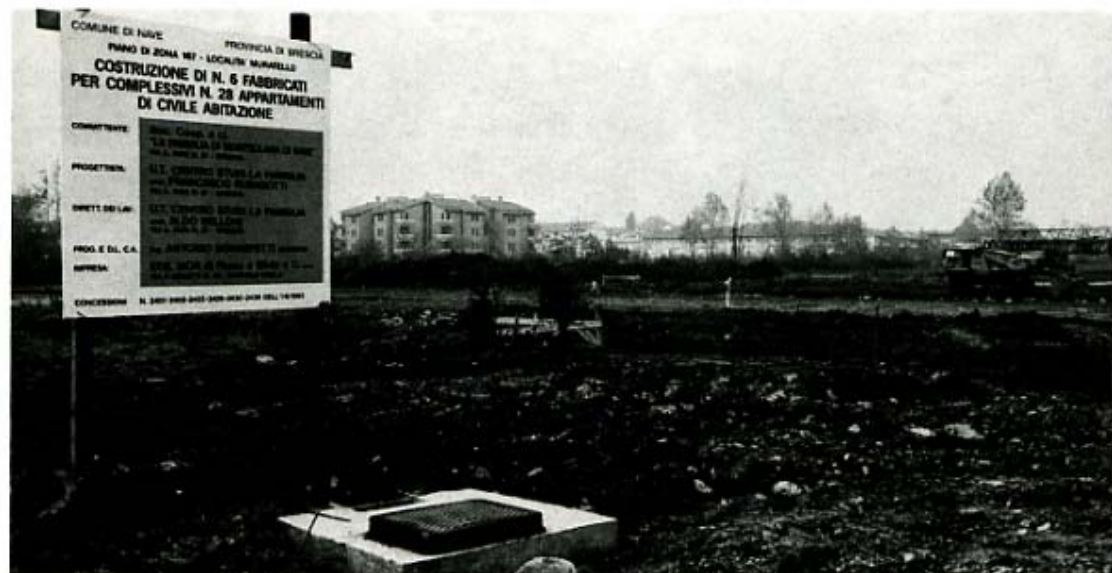
Muratello - Iniziano i primi lavori.
